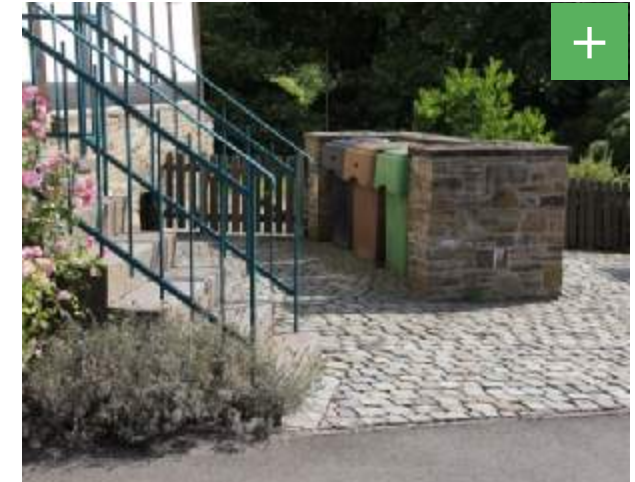
Abbildung 118: Beispiel einer Mülltonneneinhausung passend zum Gebäudesockel.
