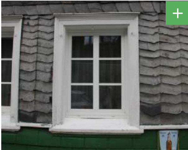
Abbildung 67: Pfostensprossenfenster als Gestaltungselement der Fassade.
