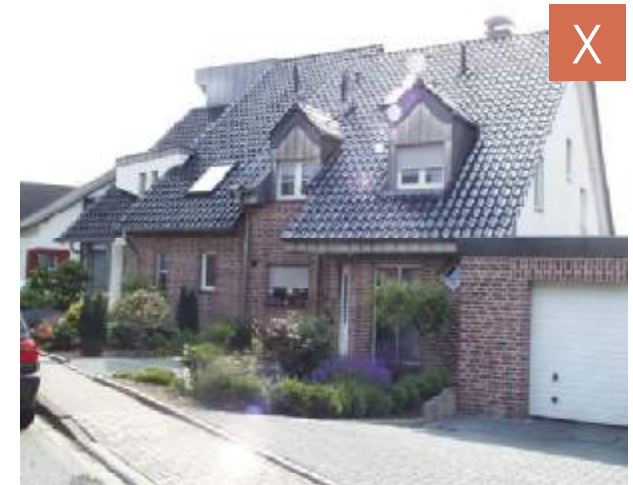
Abbildung 34: Störende Reflexionen durch glasierte Dacheindeckung.
