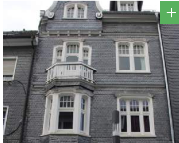
Abbildung 69: Ansprechende Fassade in Wipperfürth durch gute Fenstergestaltung.
