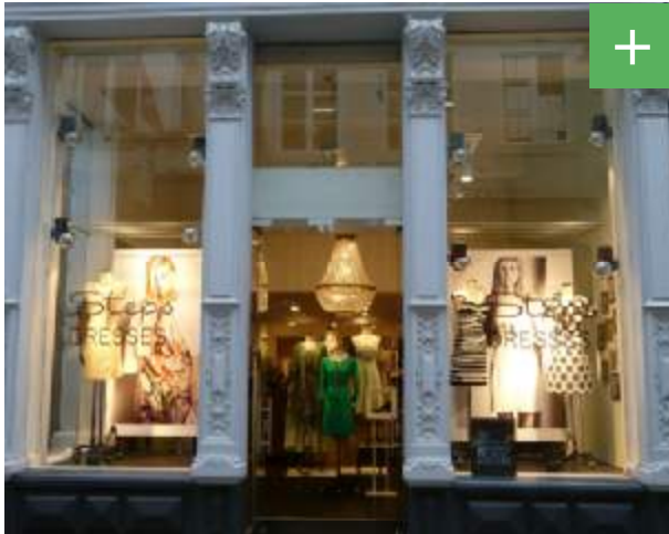
Abbildung 74: Gliederung der Schaufensterflächen durch Mauerpfeiler.
