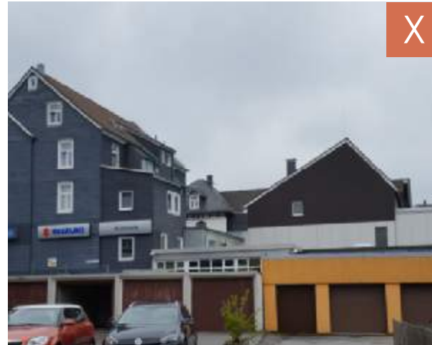
Abbildung 31: Brüche der Dachformen.
