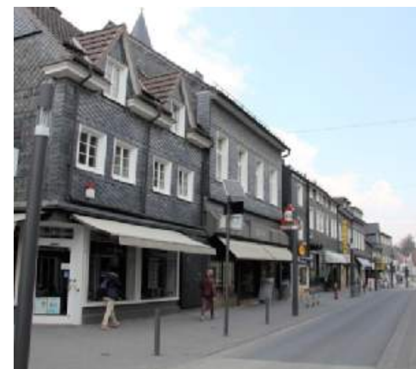
Abbildung 6: Straßenraumumgestaltung im Rahmen des InHKs: Der geplante Marktplatz und die bereits umgesetzte Untere Straße.
