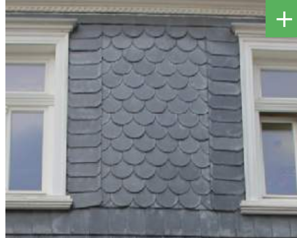
Abbildung 59: Ortstypische und hochwertige Schuppendeckung.
