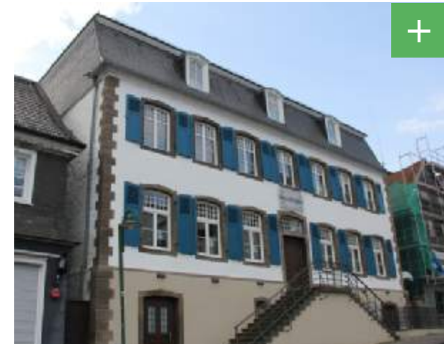
Abbildung 27: Aufwendig und gepflegt gestaltetes Schieferdach.
