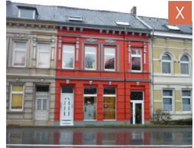
Abbildung 55: Störf Wirkung durch grelle Fassadenfarben.
