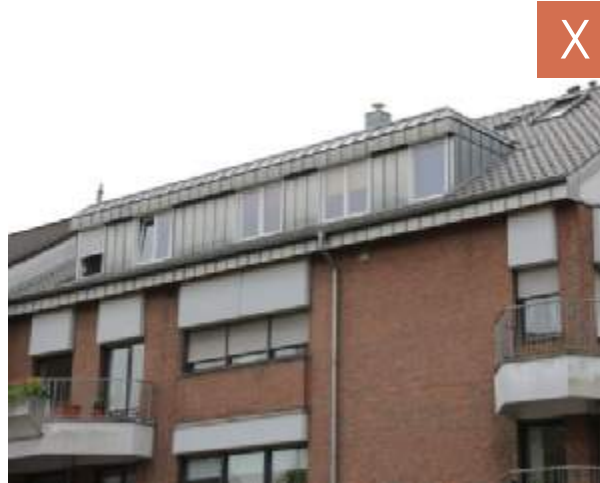
Abbildung 41: Unförmige Dachaufbauten, die fast einer Geschossaufstockung gleichen.
