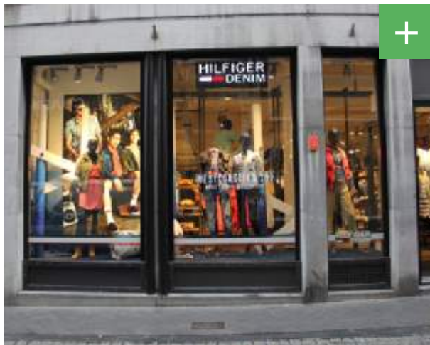
Abbildung 75: Schaufensterunterteilung durch Mauerpfeiler und Rahmenelemente.
