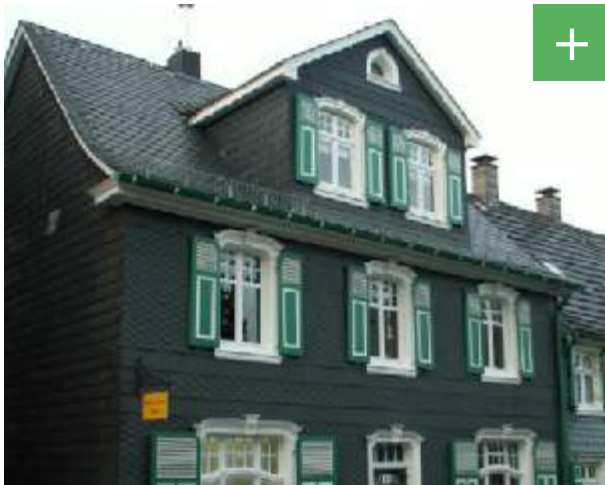
Abbildung 30: Dach mit Schieferdeckung.
