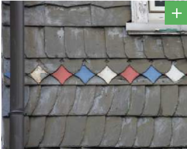
Abbildung 56: Schieferdeckung mit Gestaltungsakzenten.
