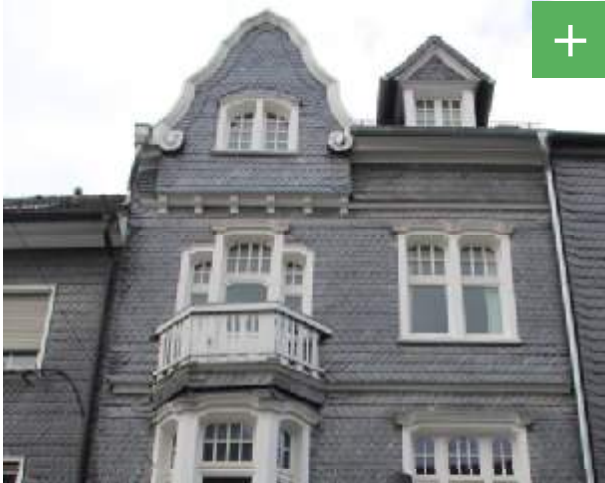
Abbildung 39: Dachaufbauten als Schmuckelemente der Fassade.
