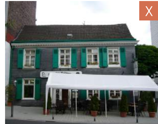
Abbildung 127: Sperrige Pavillions versperren Gehweg und Sichtbeziehungen.
