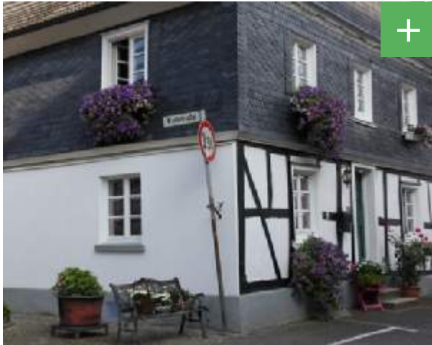
Abbildung 85: Einheitliche Bepflanzung als Fassadendekoration.
