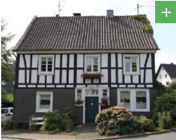
Abbildung 29: Dach mit Ziegelerdeckung.
